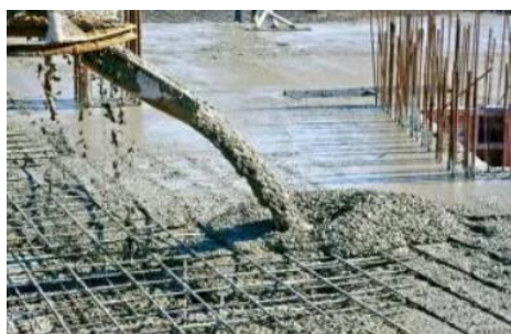
图1 混凝土浇筑施工
