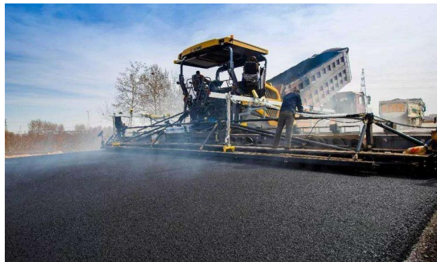
图1 面料摊铺作业现场示意图
