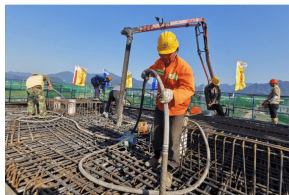
图3 桥梁工程混凝土浇筑
