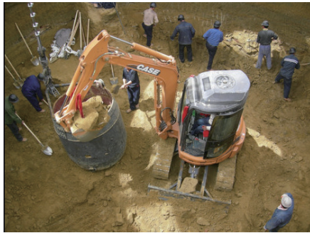
图1 煤矿施工现场图
