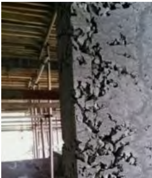
图1 混凝土蜂窝问题
