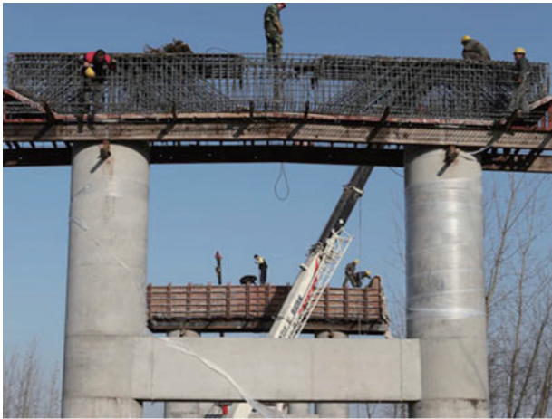
图2 市政桥梁施工图片
