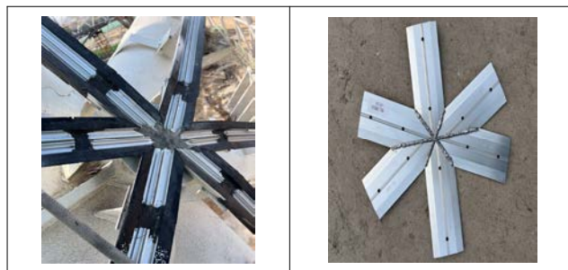
汇交点及直段拼接位置打胶处理 铝盖板汇交点焊接
