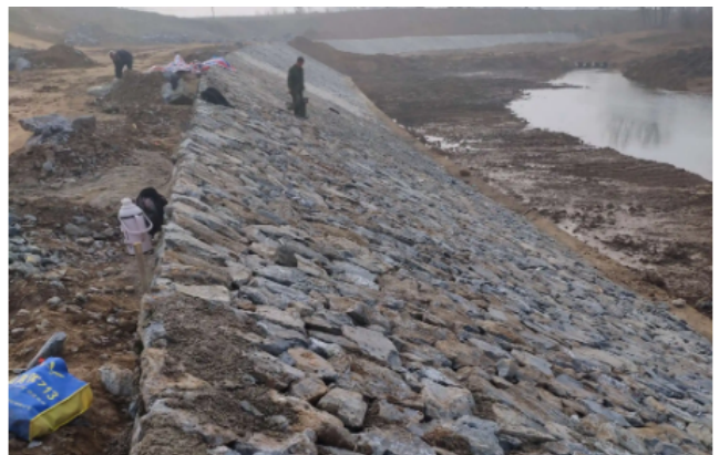
图1 公路交通运输工程浆砌片护坡
