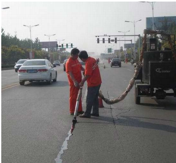
高粘度灌缝胶修复裂缝
