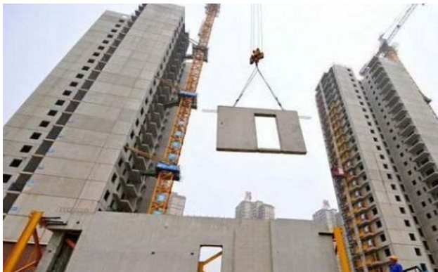
（图一：预制墙板安装）
