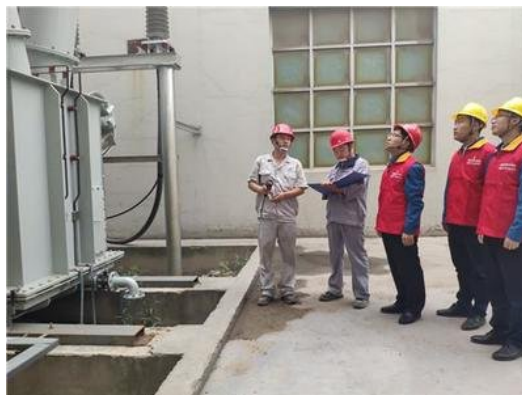
图1 电网故障检修
