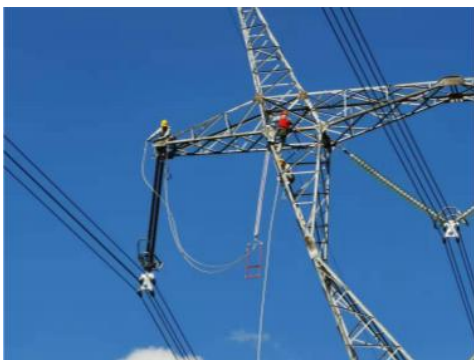
图1 带电作业操作现场
