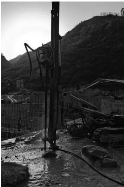
图3 灌浆防渗施工
