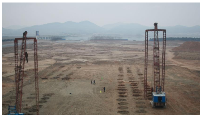
图1 地基处理强夯法施工现场
