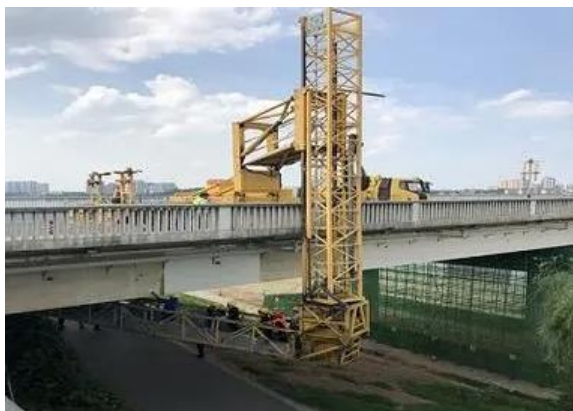
图1 对某桥梁进行检测现场
