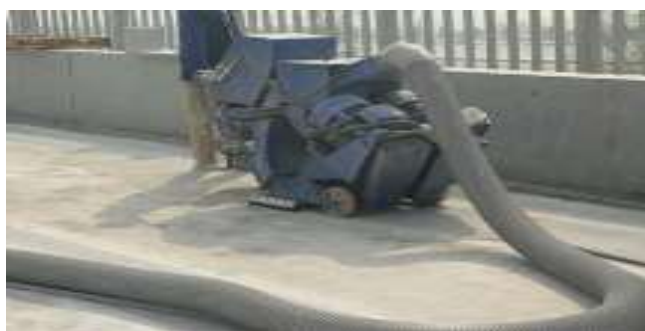
图1 抛丸施工技术应用情况
