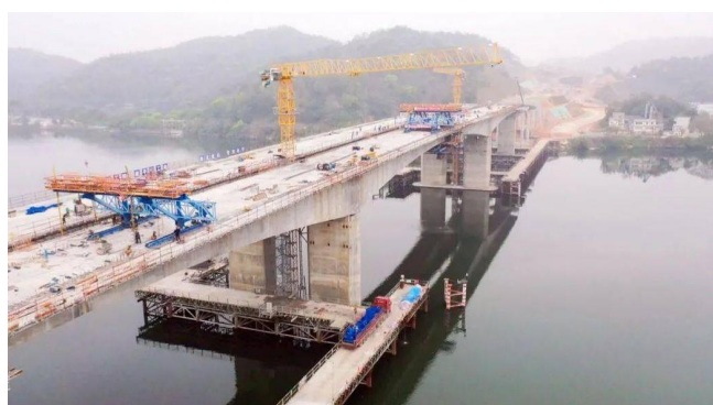
图2 桥梁路基工程施工
