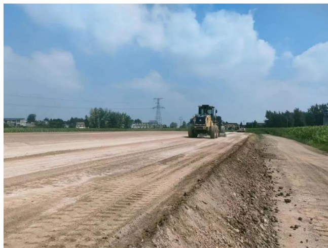
图1 桥梁路基工程施工
