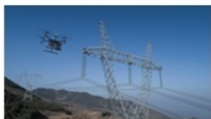
常规线路巡检
