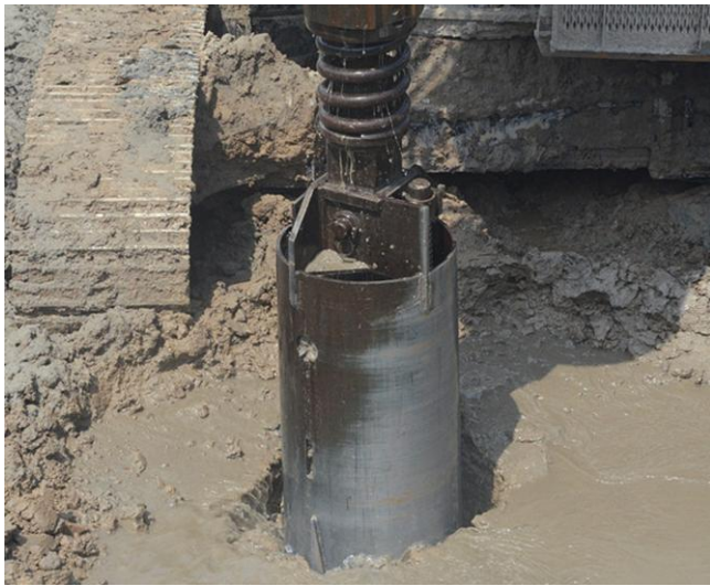
图1 钻孔灌注桩施工
