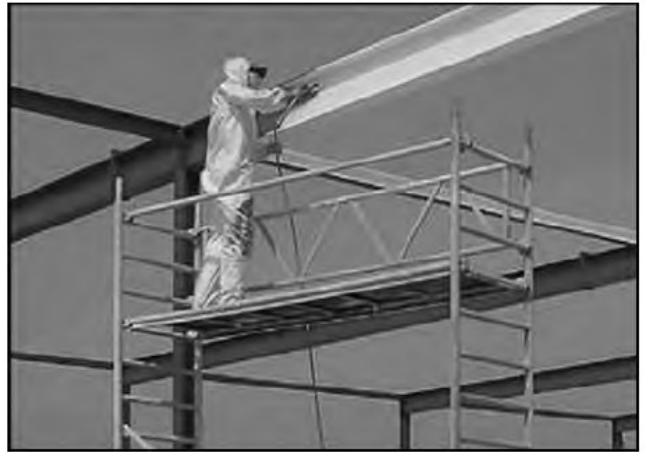
图2 钢结构防腐处理
