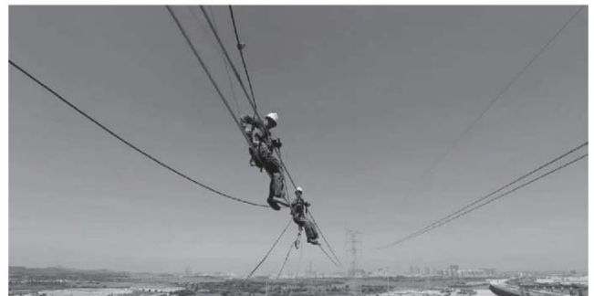
图1 输电线路监测维修
