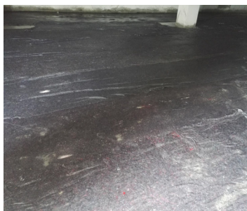
图2-2 毛毯覆盖养护
