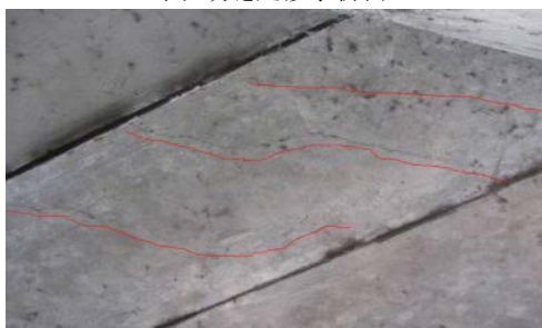
图5板底裂缝
