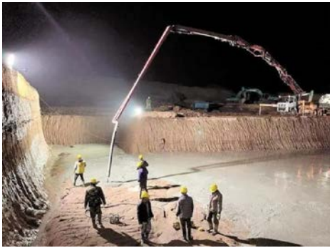
图3 水利工程混凝土浇筑
