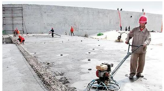
图5 冬季混凝土施工
