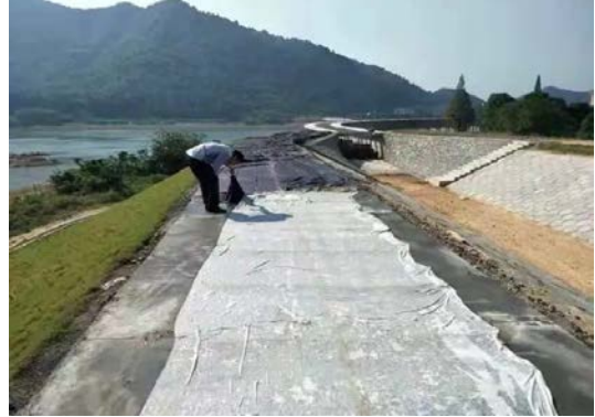
图4 混凝土洒水养护
