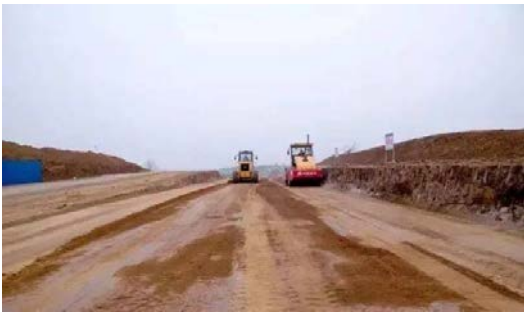
路基压实施工
