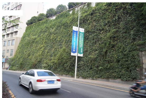
图4 某市某某路K7+148~+190—肋柱式锚杆挡墙施工完成后的现场照片
