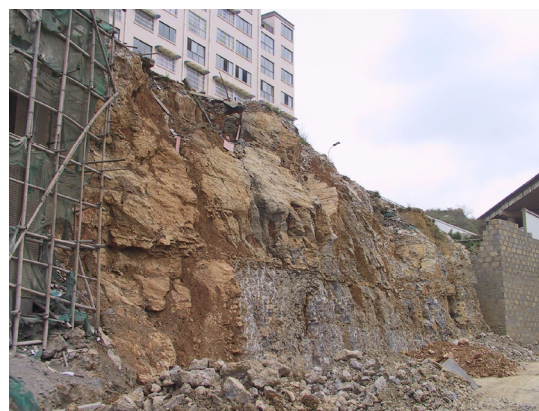
图1 某市某某路K7+148~+190段边坡未处理前地形地貌情况
