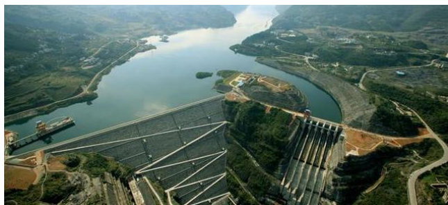
图1 水利水电工程
