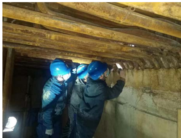
图2 锅炉受热检修
