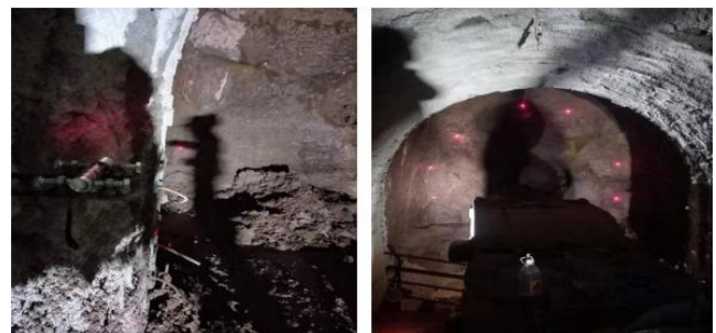
图4 红外线超欠挖控制导向仪
