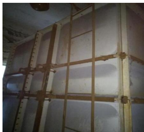
图1 现场水箱局部图
