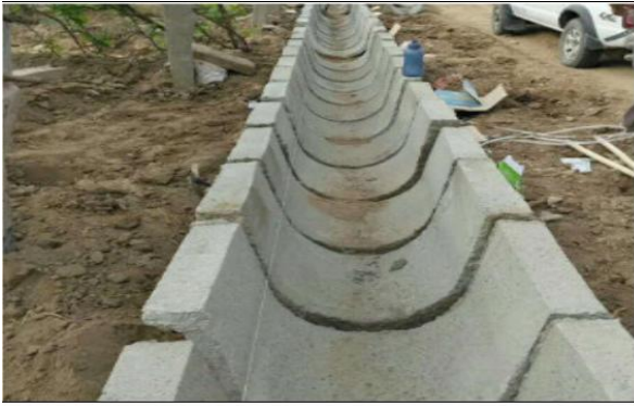
图3 混凝土衬砌渠道
