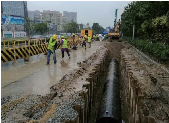
图1 市政工程施工现场图
