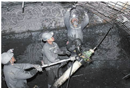
图1 煤矿施工现场图
