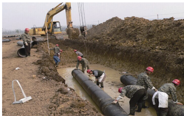
图1 市政工程施工现场图
