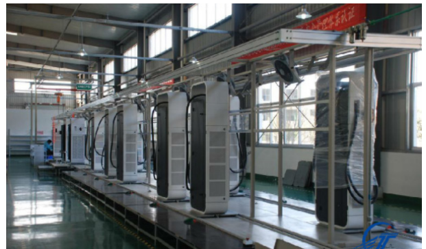
图1 交流充电桩生产线
