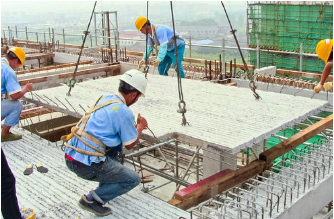
图1 建筑施工现场
