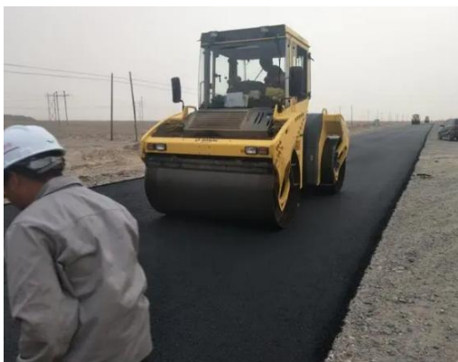
图2 沥青碾压施工现场图
