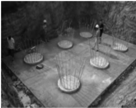
图1 桩基施工现场
