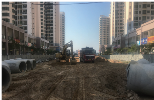
图2 市政工程施工现场
