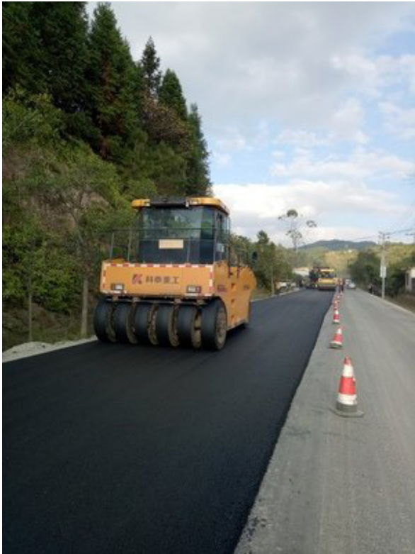
路面沥青摊铺
