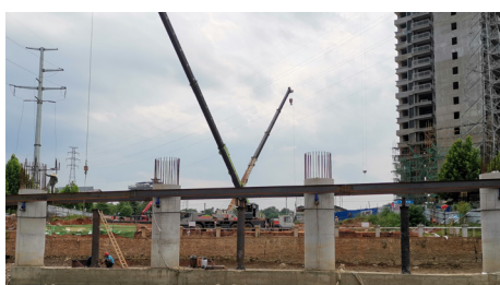
图2: 盖梁施工环境
