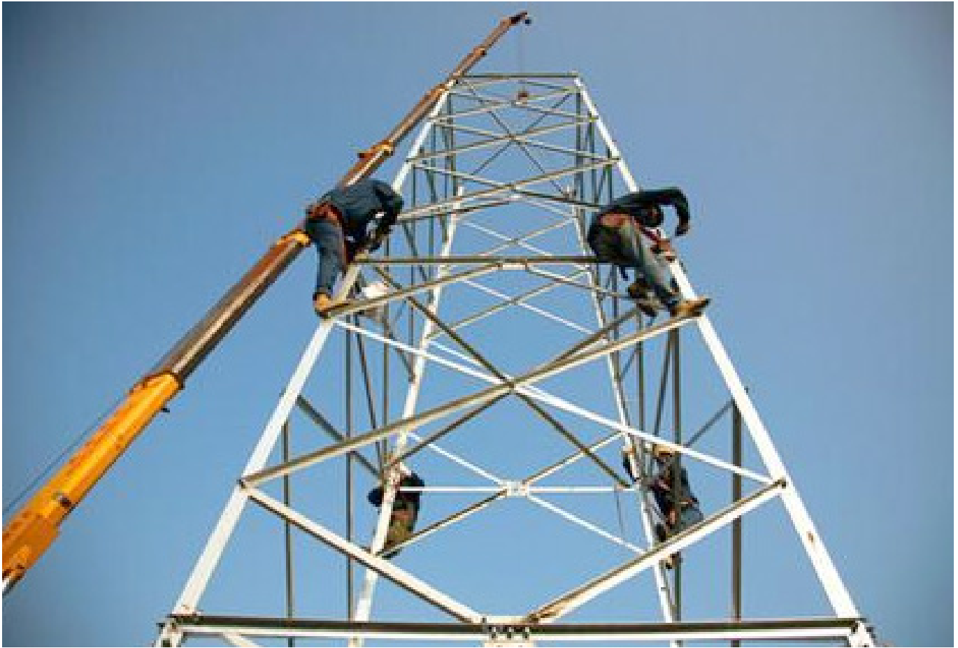
图1 高压输电线路立塔现场
