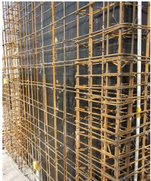
图3 剪力墙钢筋绑扎
