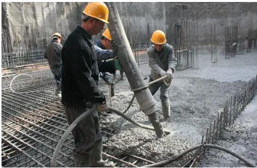
图1钢筋混凝土振捣
