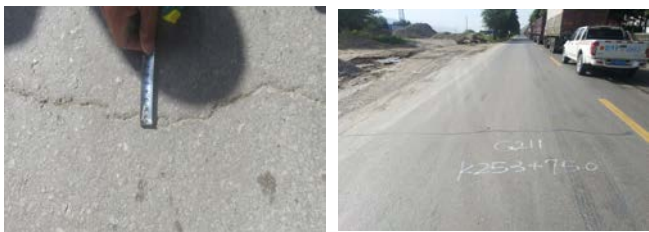
图2 G211线k253+750处利用路面贴缝胶处理路面裂缝效果明显
