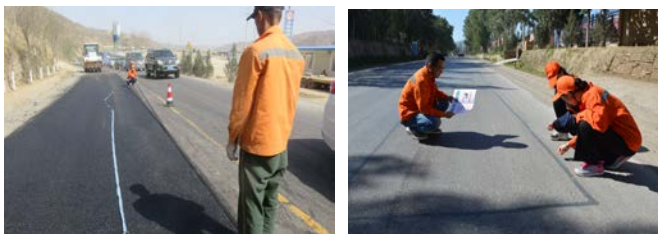
图3 G211线油路修补处理接茬贴缝，防水效果明显
