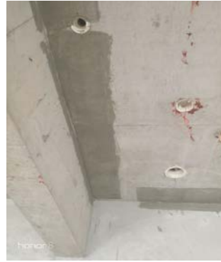
图6 梁侧边修补效果
