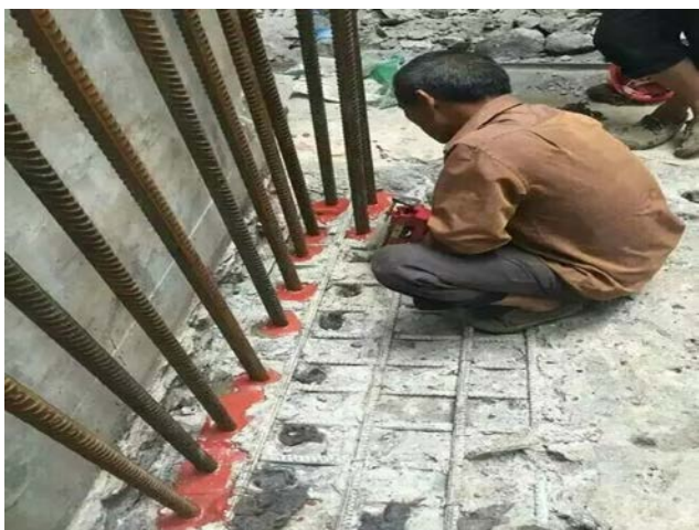
图1 植筋加固技术
