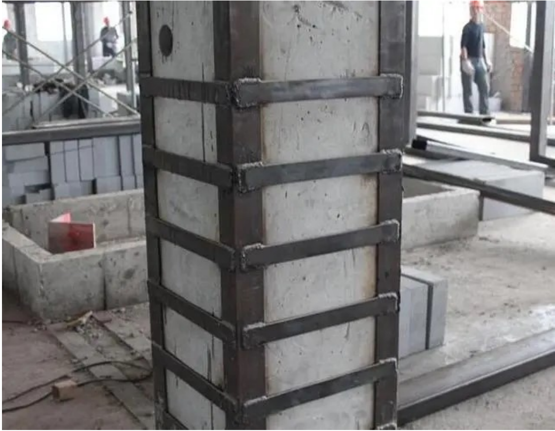
图3 外包钢加固技术
