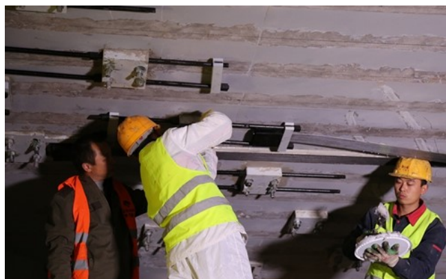
图2 体外预应力加固技术
