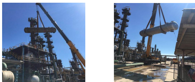
图4 现场EA1460吊装图片
