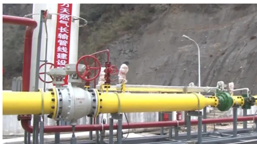
图1 户外长输天然气管道工程
