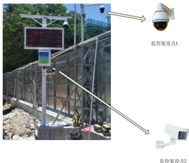
图1 施工现场无线监控架设
