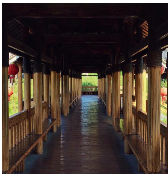
图1-3 风雨桥内部图
